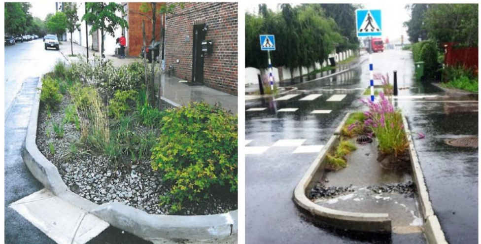
Figur 14. Exempel på regnbädd. Till vänster: det är viktigt att inloppet placeras på rätt nivå så att avrinning från ytor kan enkelt komma in i anläggningen. Till höger: Viktigt att tänka på är att strax vid inloppet behövs erosionsskydd (till exempel ett lager med makadam) att finnas så att fyllermaterialet förhindras från att spolats ut vid höga flöden. (Godecke-Tobias Blecken 2016)
