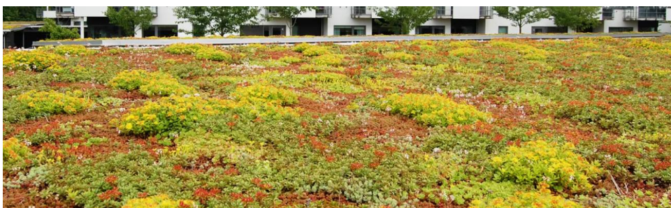
Figur 24 Sedumtak (Foto: Vegtech)
