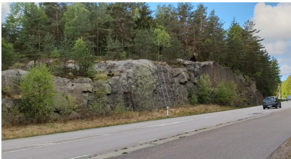
Figur 4. Vy västerut på Spårhagavägen som visar bergskärningen i innerkurvan.
