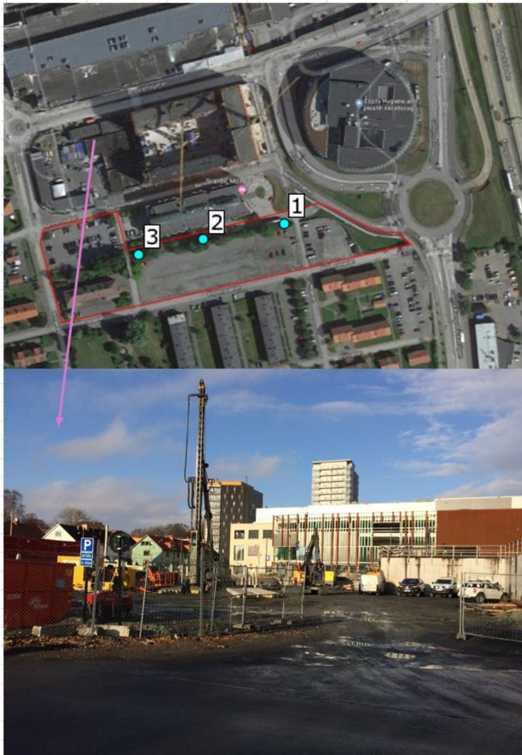
Figur 7 Positioner för Mp1, Mp2 och Mp 3 samt bild på pålningsverksamhet som påverkar dagmätningar
