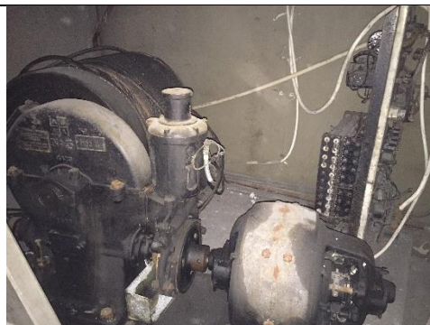
Figur 18. Prov 18. Olja i äldre hissmaskin plan 3. Låga halter PCB (0,27 mg/kg).
