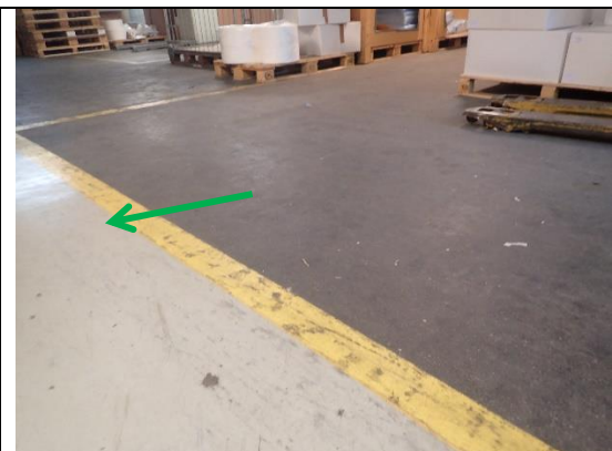
Figur 19. Prov 1, byggnad 110. Svart golvmassa. Ej PCB.
