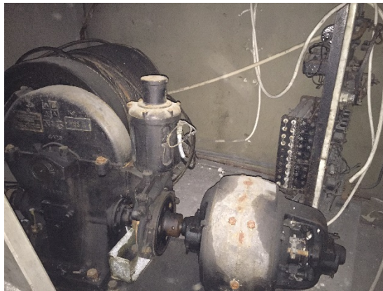
Figur 9. Äldre hiss rum med oljor spill på golv. Prov 18 olja i maskin visade låga halter PCB (0,27 mg/kg).
