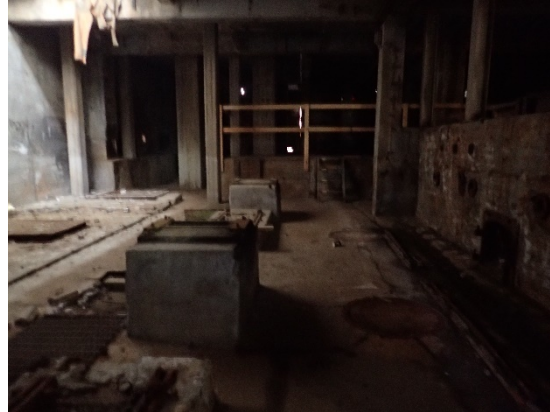
Figur 13. Rester av fundament till pannor i källare by 14, f.d panncentral. Inget oljespill eller oljelukt noterades.
