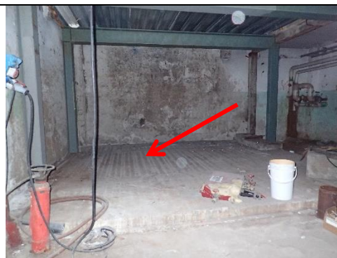
Figur 2. Prov 2. Samlingsprov bös på golv plan 2 by 16. Förhöjda halter av tungmetaller.
