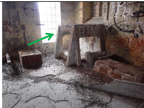
Figur 14. Prov 14. Samlingsprov kitt industrifönster by 10.-ej asbest.
