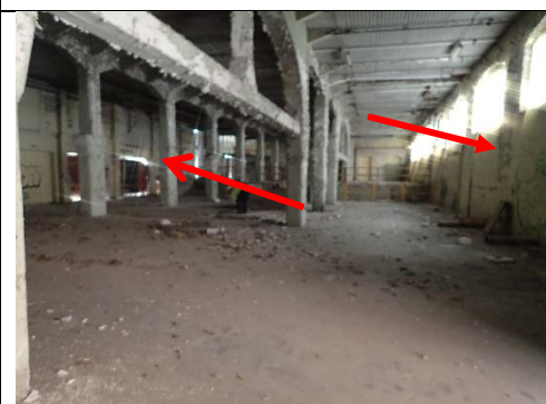
Figur 3. Prov 3. Samlingsprov färgflagor på väggar by 17. Höga halter tungmetaller.
