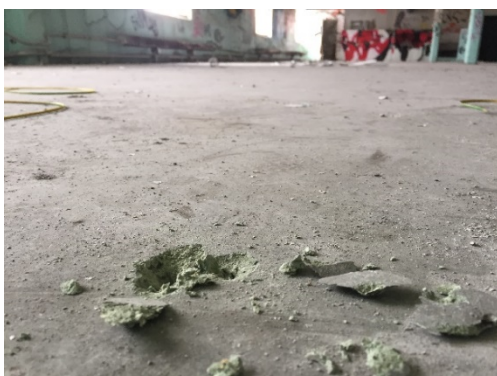
Figur 18. Foto by 18 (plan 4) där det finns ett grönt massagolv som innehåller asbest.
