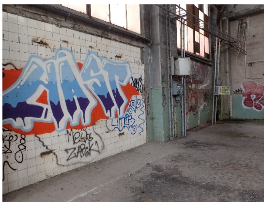
Figur 5. Höga halter av bly i äldre kakel. Här foto från by 14 f d panncentral.
