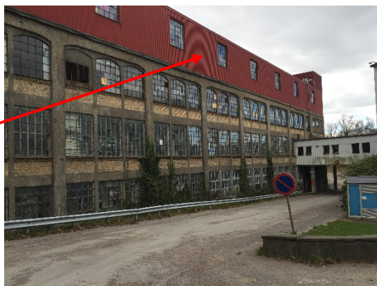
Figur 23. Gammamätningar på plan 4 i by 18 visar att den utgörs av blåbetong.
