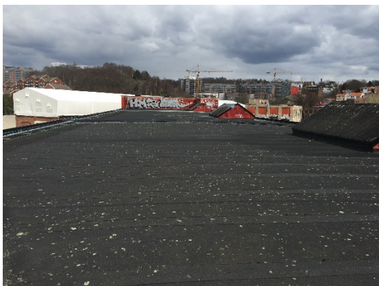
Figur 14. Foto från tak by 18. Nyare isolering och papp i de övre lagren.
