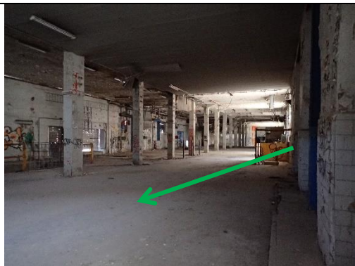
Figur 7. Prov 7. Svart massagolv (asfalt) plan 1 by 10. Låga halter PAH (PAH16 4,3 mg/kg).
