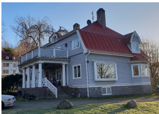
Figur 28. Rudströms villan, tjärad papp finns med stor sannolikhet under plåttak och i väggar.
