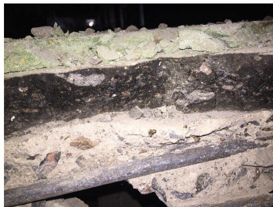
Figur 15. Foto från by 18, här finns asfaltsbeläggningen delvis i ytan och delvis under ett grönt massagolv som innehåller asbest, se nedan.
