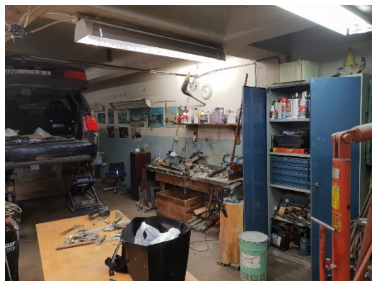
Figur 17. Hobbyverkstad på bottenplan, här finns oljeskadade betonggolv.
