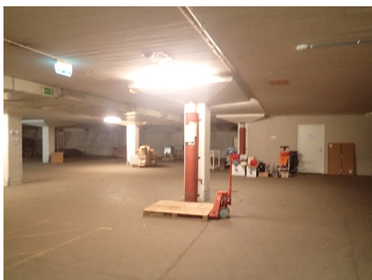
Figur 16. Lagerhallar i alla plan i by 110 har asfaltsbeläggningar på golven, äldre ventilation, rör och branddörrar som kan innehålla asbest.
