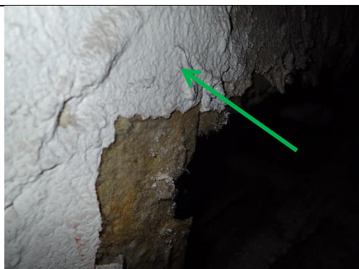
Figur 15. Prov 15 sprutisolering innervägg plan 2 hus 10-ej asbest.
