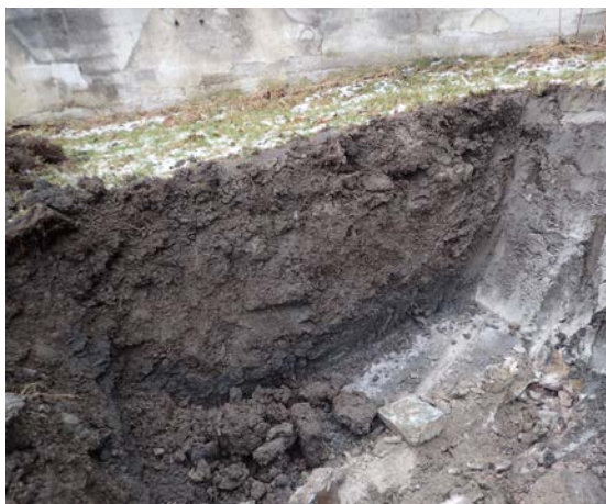
Figur 8. Vid provgropsgrävningen vid f d bussgarage påträffades den gamla betongplattan. Här i PG 2. Figur 9. En del fasta rivningsrester påträffades i flera provgropar vid f d bussgarage. Här i PG 7.
