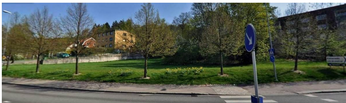
Figur 2. Endast byggnadens stödmurar återstår.
