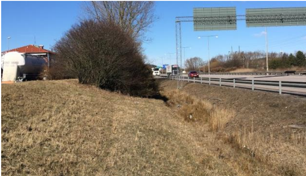
Figur 13. Utmed E6 går en vall som hindrar eventuella avåkande fordon från att lämna vägområdet. Dessutom bildar vällen ett dike som begränsar spridningsavståndet vid ett utsläpp av farligt gods.
