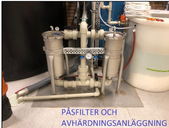
Figur 7, Avhärtningsanläggning i hus MD
