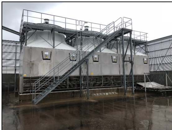
Figur 3, Kyltornet placerat på MK:s tak.
