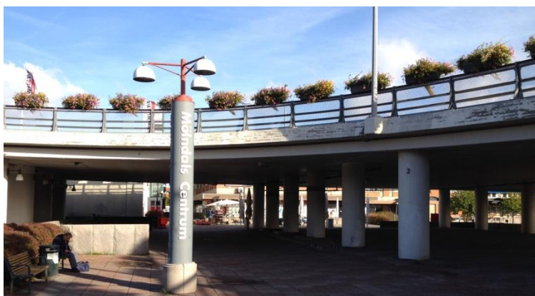
Figur 3.2. Nygatan, vy mot norr och passagen under bron som leder fram till Brogatan
