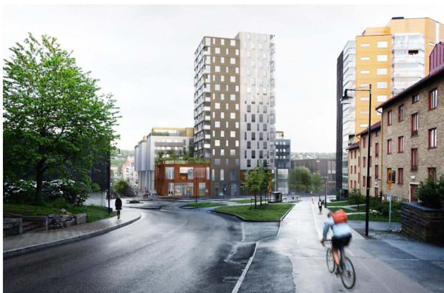
Figur 3.13. Visualisering av entré från väst med det planerade höghuset i kvarteret Hajen i blickfånget.
