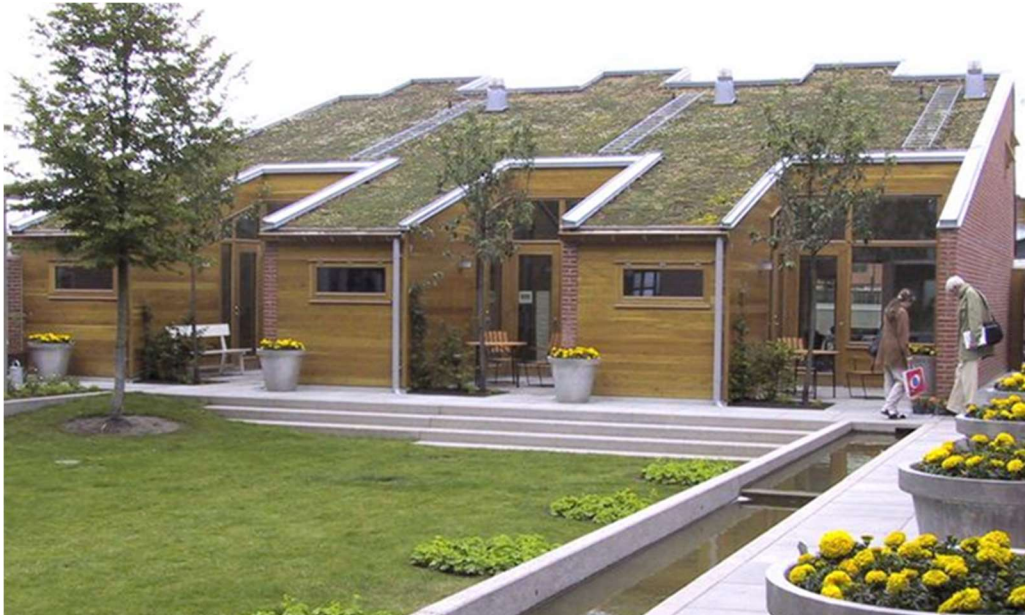
Figur 3. Malmö. Lokalt omhändertagande av dagvatten i form av gröna tak samt öppna kanaler. (Vegtech, u.d.)
