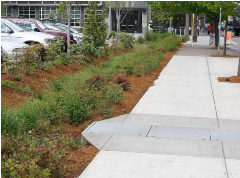
Figur 11. Parkeringsplats med avledning till regnträdgård. (Escholarship, u.d.)
