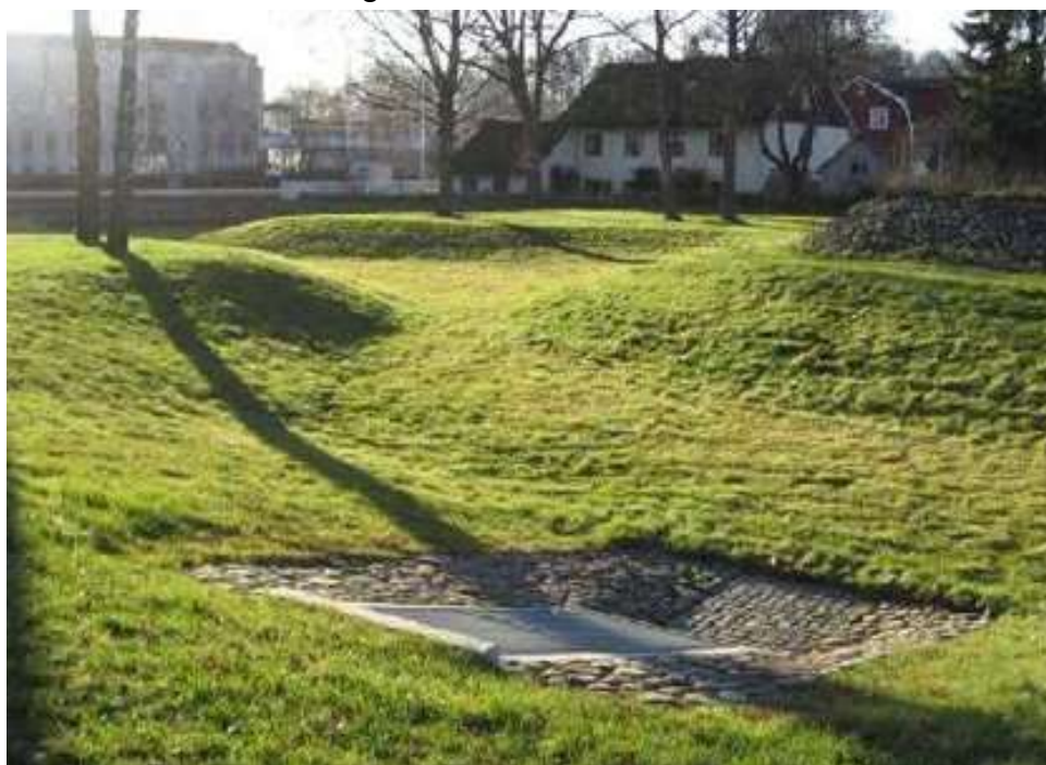
Figur 21. Yta för rekreation som tillfälligt kan svämmas över och användas för att fördröja dagvatten. (Härryda kommun, 2011)
