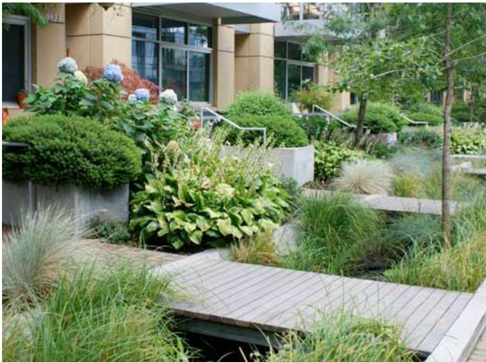
Figur 12. Kanalen avvattnar och avleder dagvatten från bostadsområdet. Anlagda gångbroar förbinder kvartersmarken med den allmänna. (Huddinge kommun, 2014)
