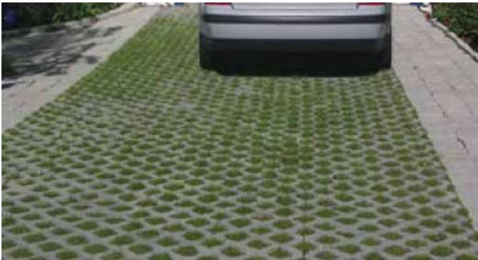
Figur 10. Genomsläpplig rasterbeläggning på parkeringsplats. (Uppsala vatten, 2014)
