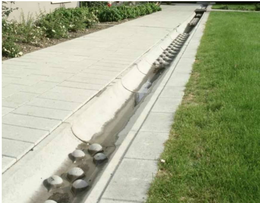
Figur 17. System med breda dagvattenkanaler för öppet dagvattensystem, de lökformade kupolerna ökar vattnets strömningshastighet samt leder till en förbättring av rensningen i rännan vid låga vattenflöden. (St: Eriks, 2016)
